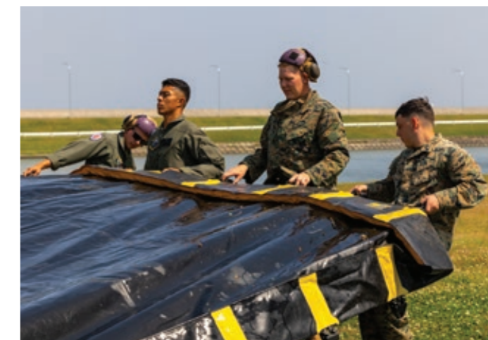
前方武装給油ポイント (FARP) 訓練で燃料バームを設置する第171海兵師団支援中隊 (MWSS-171) と第242海兵戦闘攻撃中隊 (VMFA-242) の海兵隊員たち。 U.S. Marines with Marine Wing Support Squadron 171 and Marine Fighter Attack Squadron (VMFA) 242 set up a fuel berm during forward arming refueling point training.
