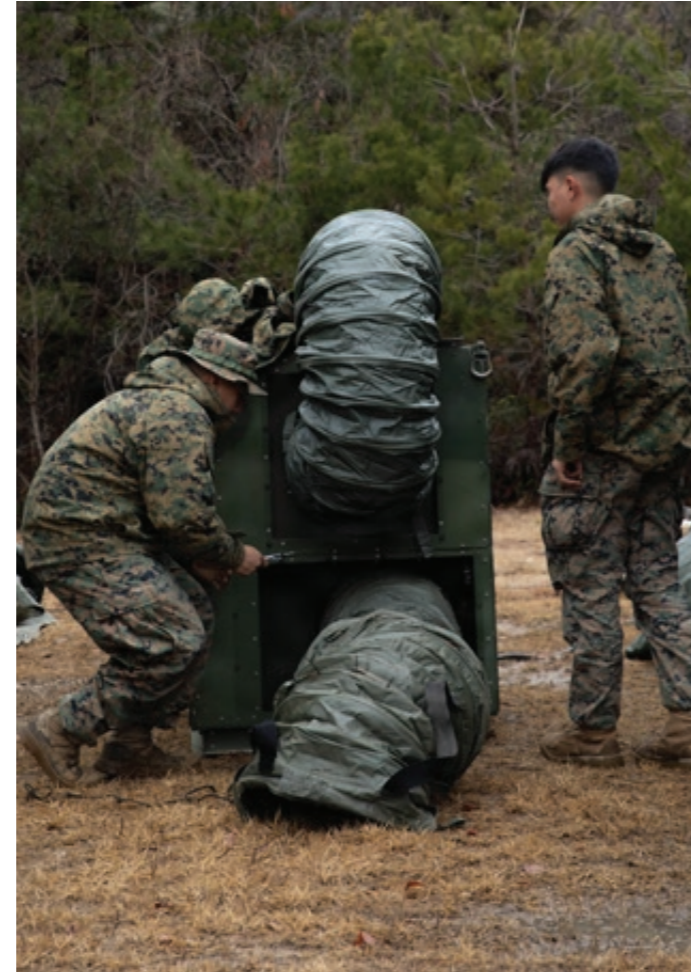
3月6日、広島県の原村演習場で実施された野外訓練中に発電機のメンテナンスを行う、第1海兵航空団 第12海兵飛行大隊 第171海兵航空師団支援中隊所属の米海兵隊員たち。 U.S. Marines from Marine Wing Support Squadron 171, Marine Aircraft Group 12, 1st Marine Aircraft Wing, conduct maintenance on a generator during a field training exercise at Haramura Training Area, Hiroshima, Japan, March 3, 2026.
