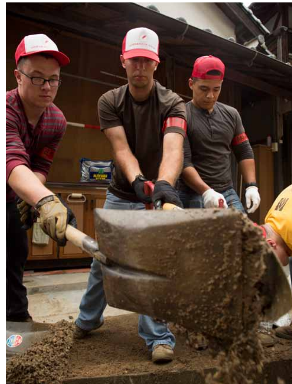
8月上旬の豪雨災害で被害を受けた岩国市砂山町の住宅で8月14日、ボランティアに参加した(写真左から)アレックス・エスカンドン兵長、ドミニク・グリフィス兵長、ロベルト・アレヤノ兵長が側溝の泥を片付けている。
